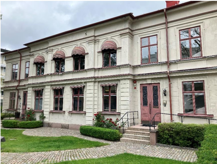
Fotot visar söderfasaden av Godtemplarordens hus (foto: Växjö kommun)
