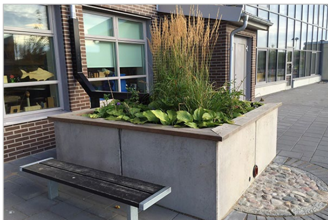
Figur 10. Exempel på upphöjd regnbädd för takvatten, källa: Hekla regnbädd - Bara Mineraler
