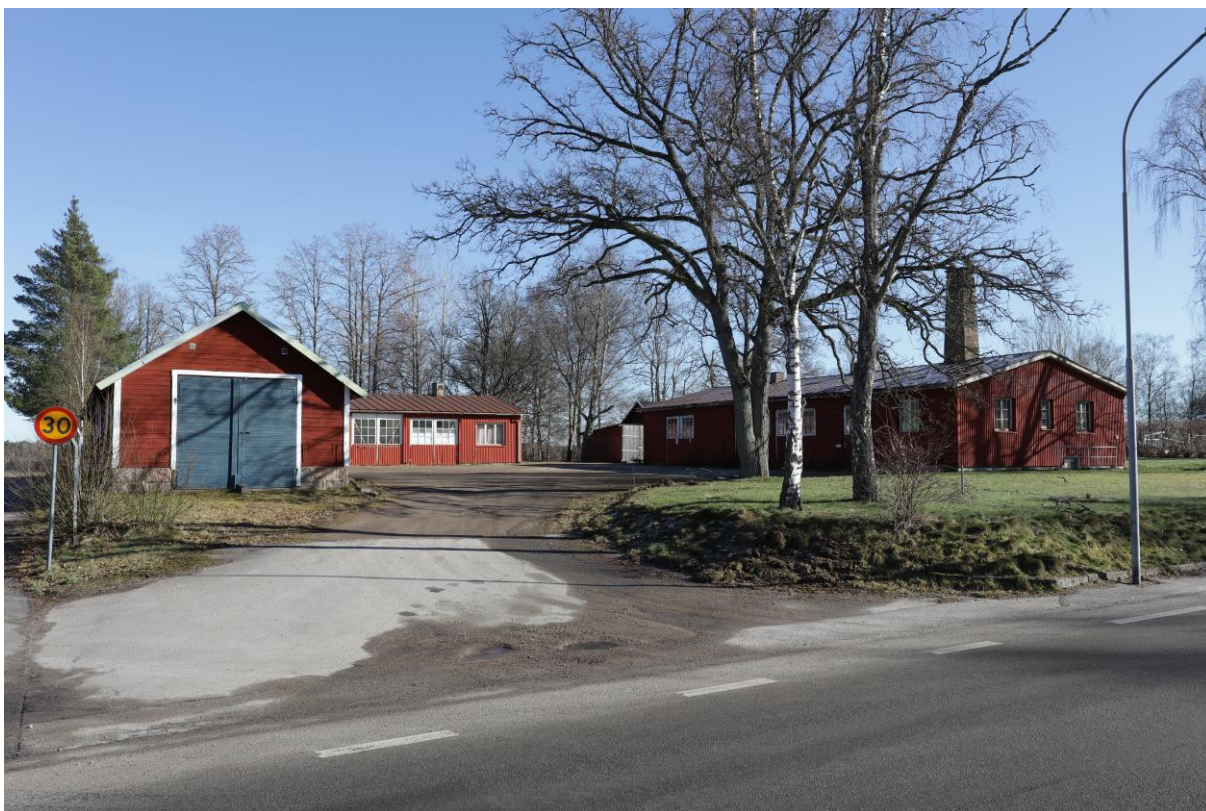
Vägstationen i vy mot öster, 2023. Jämför med bilden ovan. Bägge fotona är tagna på ungefär samma plats vi Gamla Växjövägen. Notera att båda byggnaderna från 1942 med putsade fasader idag är klädda med plåt.
