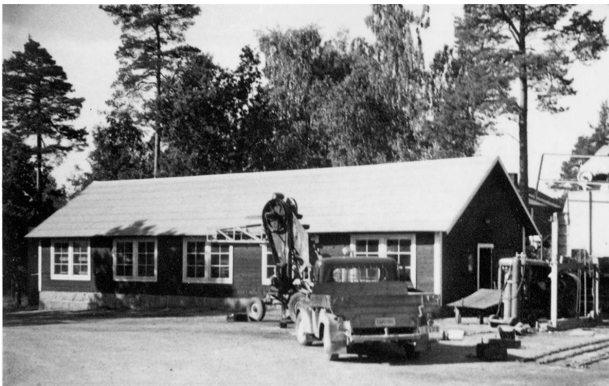
Foto av förrådsbyggnad nr 6, Ingelstad vägstation, från sent 1940-tal eller tidigt 1950-tal. Foto: Väg- och trafikhistoriska samlingen
