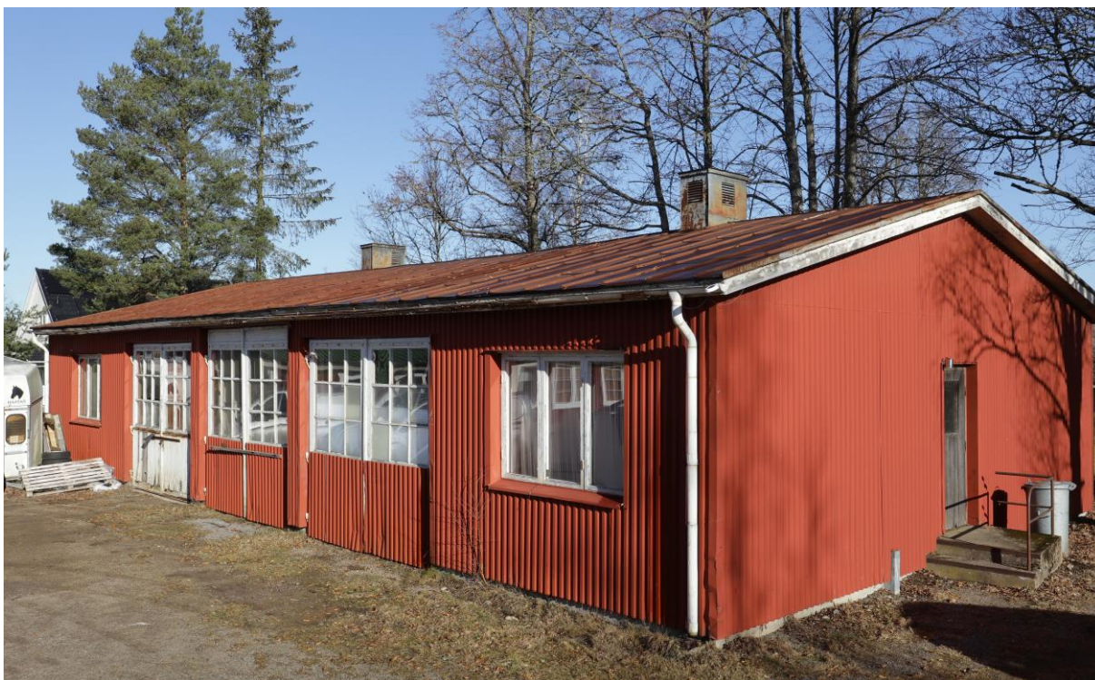
Garage med smedja, sydfasad med garageportar, 2023.
