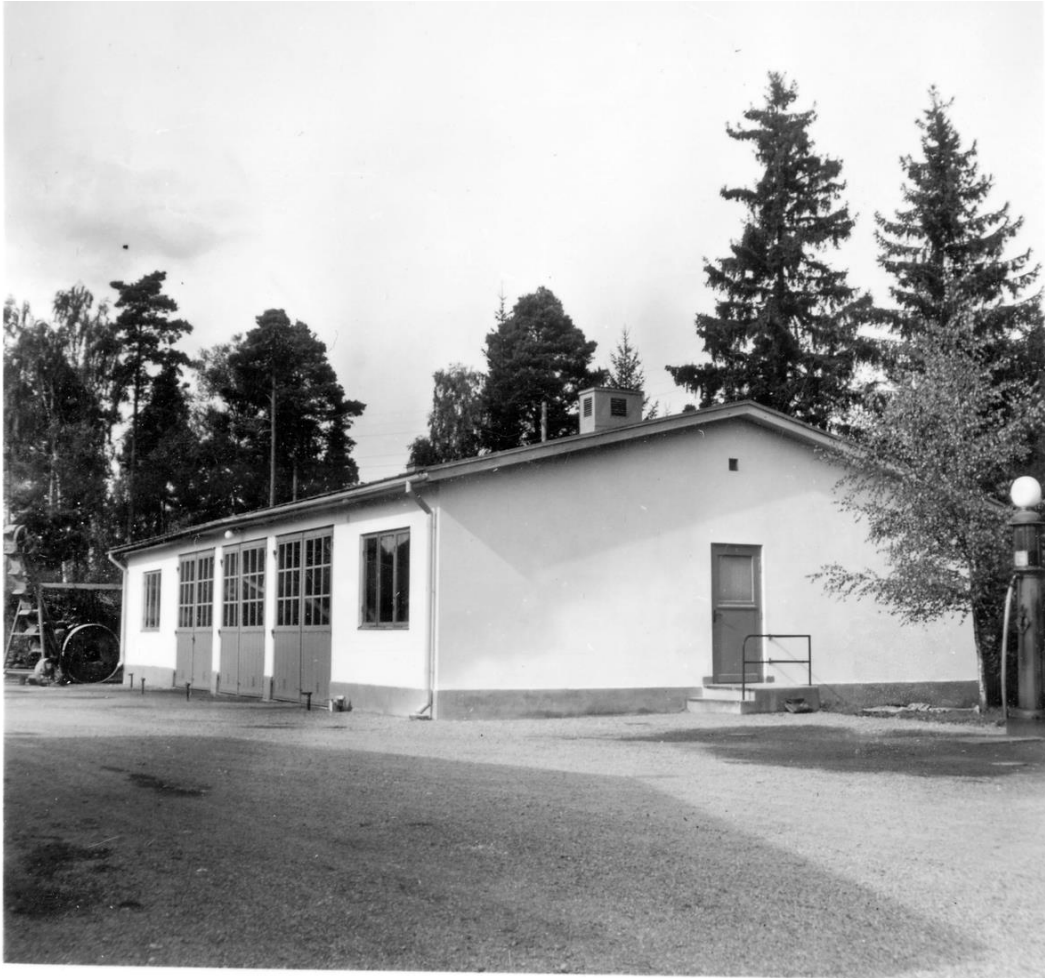
Garage med smedja. Foto från sent 1940-tal eller tidigt 1950-tal. Till höger syns en av tre bränslepumpar som fanns på platsen. Foto: Väg- och trafikhistoriska samlingen
