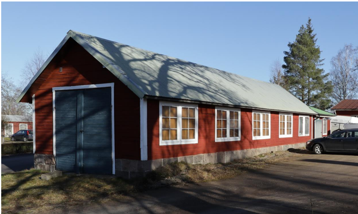
Förrådsbyggnad (hus 6), 2023. På östra långsidans fasad, till höger i bild, finns en nummerskylt som anger nr "6". Byggnaden bedöms exteriört mycket välhållen och är viktig ur ett miljöskapande perspektiv. Byggnaden bör bevaras som en rest av den gamla vägstationen.
