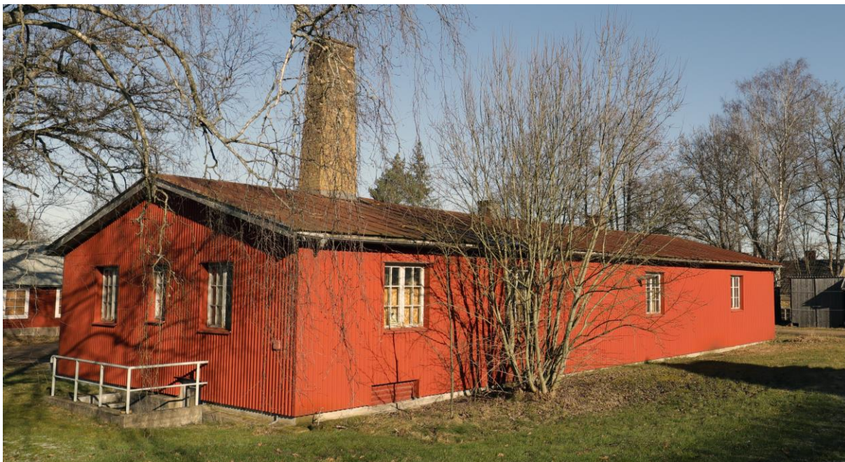
Garage med kontorsdel, södra gaveln och östra långsidan, 2023. Kontorsdelen är placerad närmast byggnadens södra gavel, till vänster i bild.
