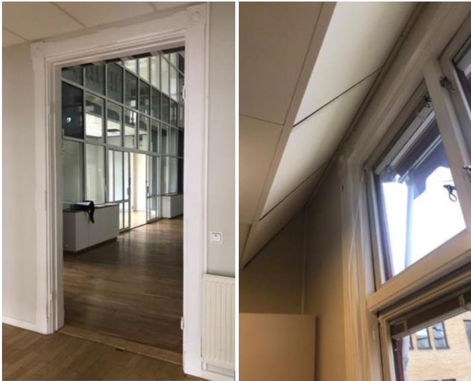
Dörr och fönster med profilerade foder (foton: Paul Hansson, WSP).
